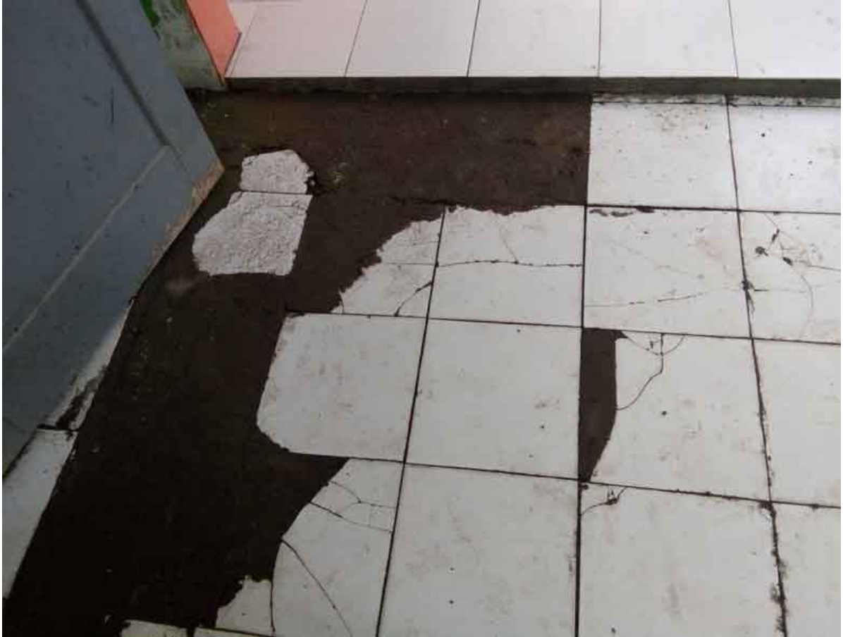
Lantai Jamban Siswa Putri
