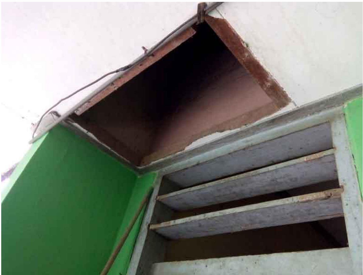
Plafon Jamban Siswa Putri
