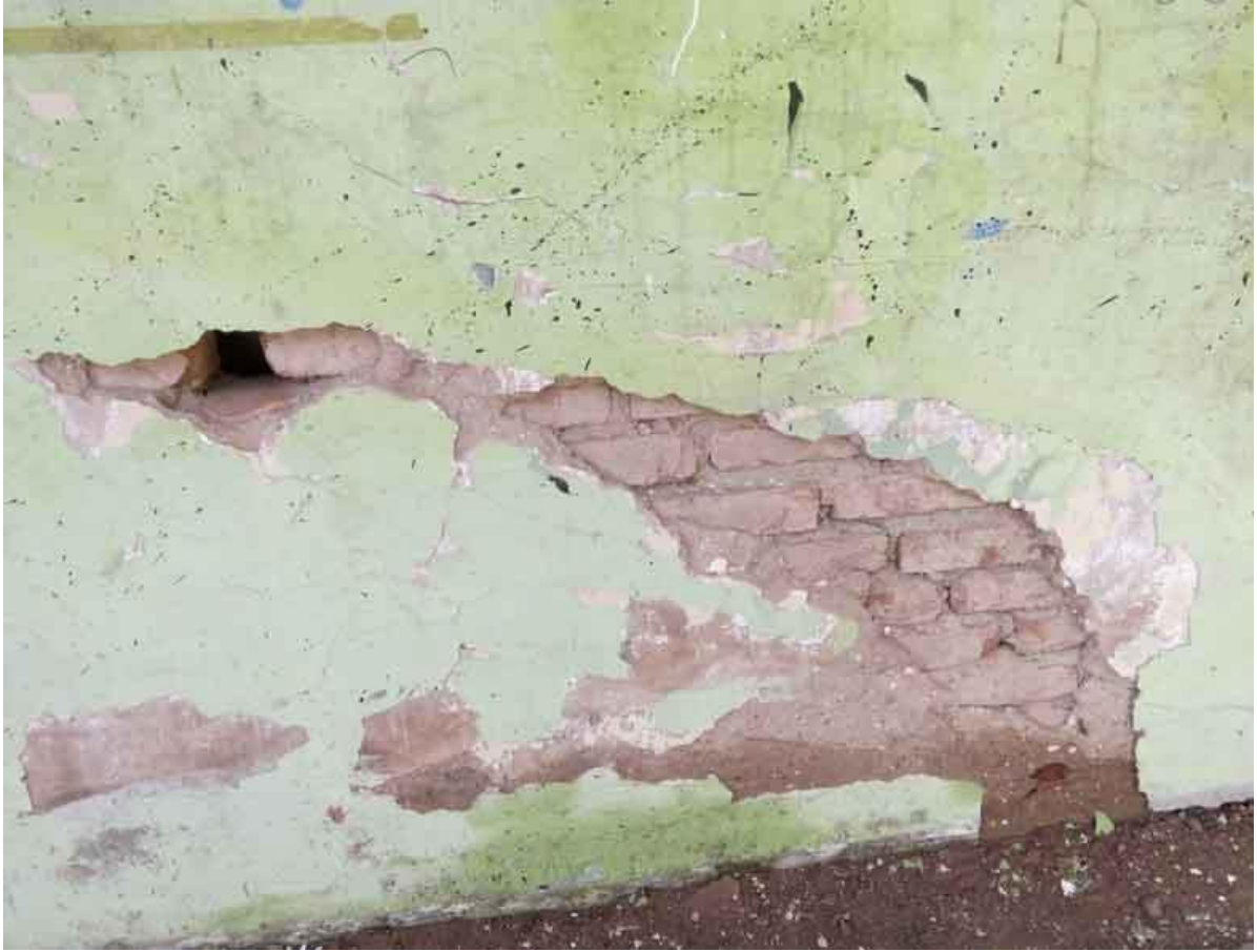
Tembok Dinding Ruang KS
