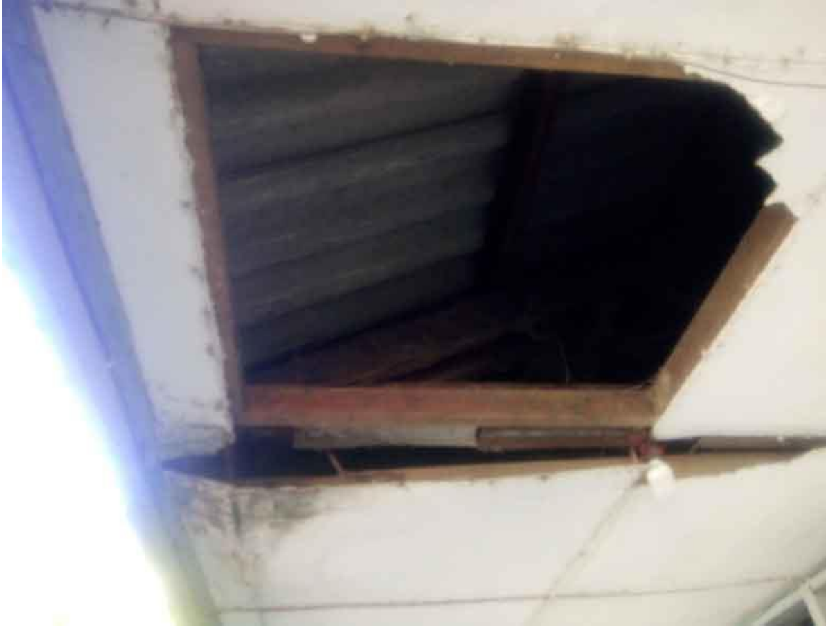
Plafon teras Perpustakaan
