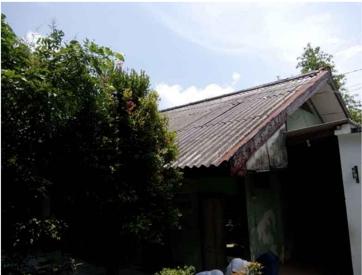
Atap ruang jamban Guru
