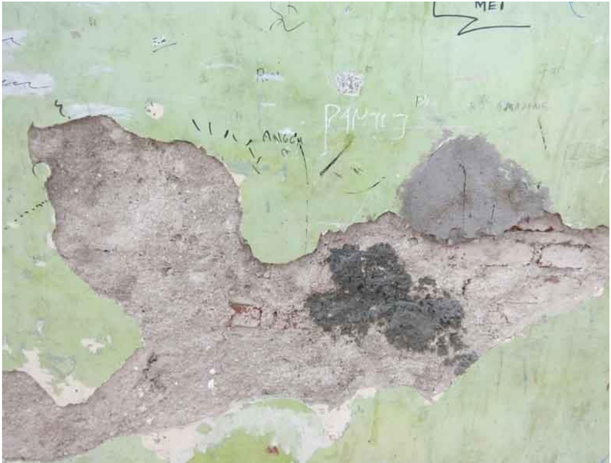
Tembok Jamban Siswa Putri
