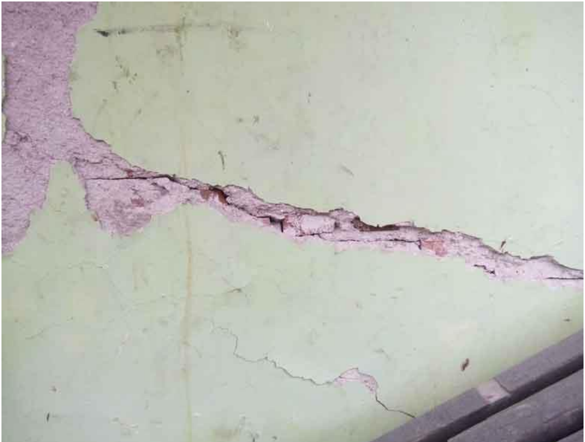
Tembok Dinding Ruang TU
