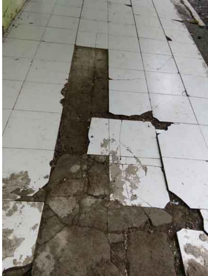
Lantai Teras Jamban Putri
