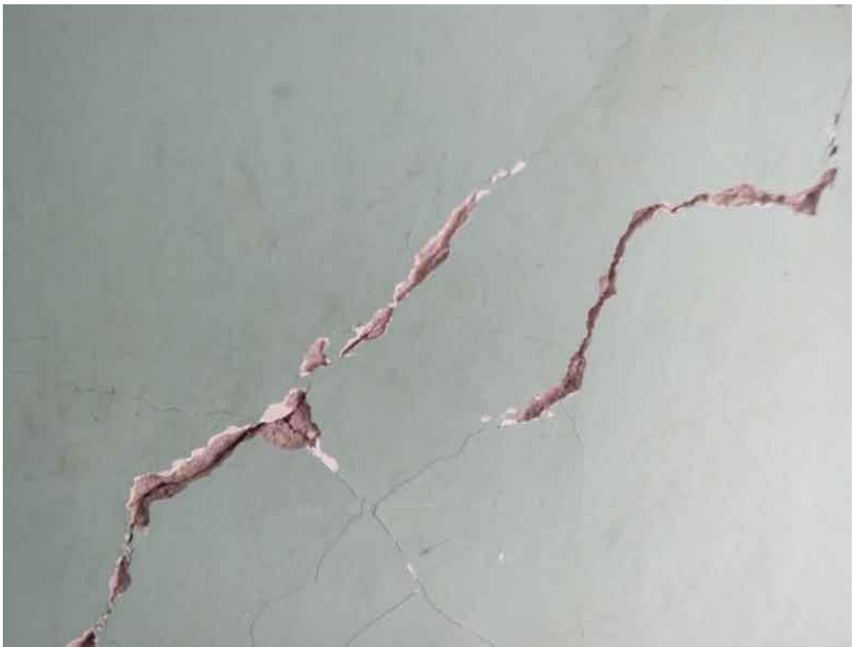
Tembok Dinding Ruang KS
