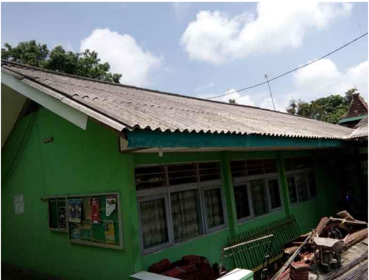
Atap ruang jamban Guru
