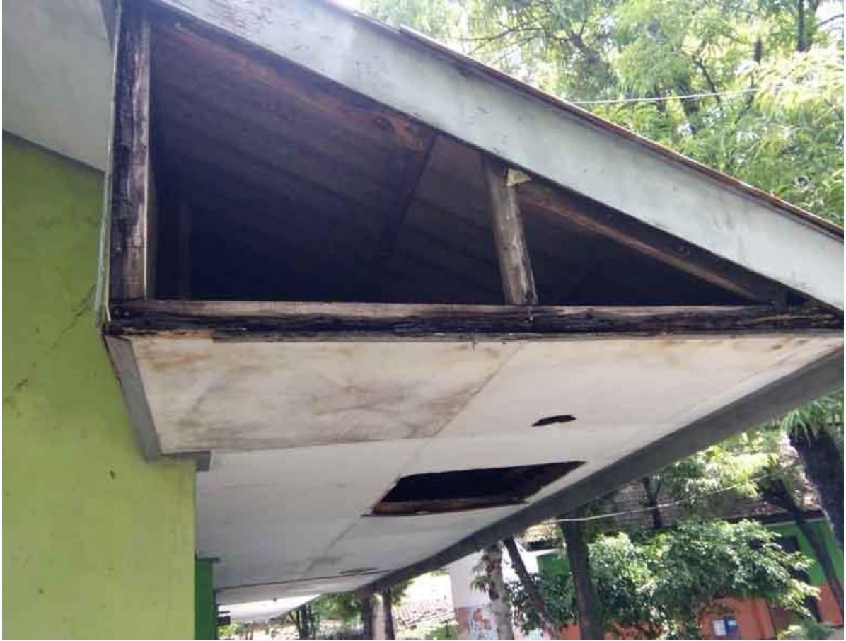
Plafon Teras ruang TU
