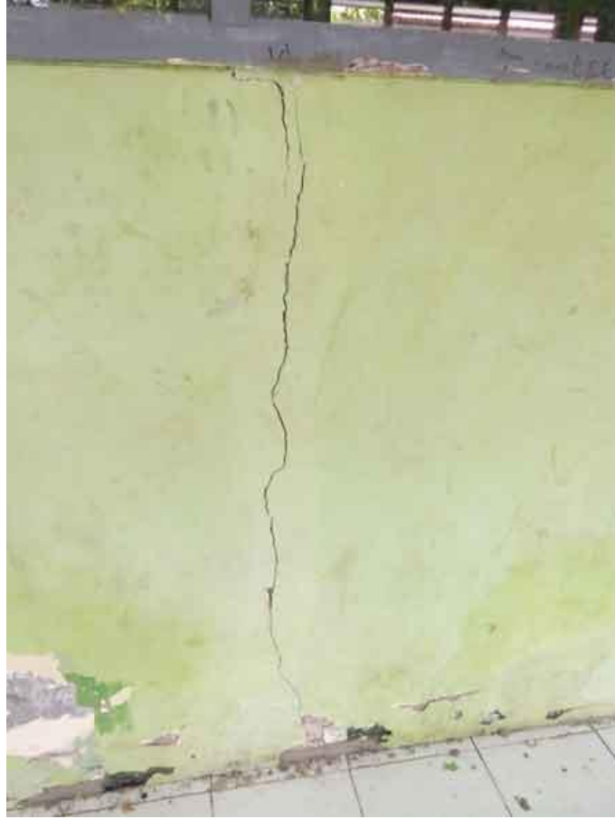
Tembok Dinding Ruang TU
