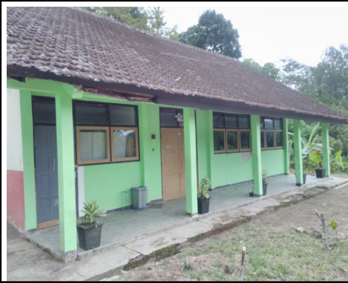
Ruang Kelas - Tampak depan
