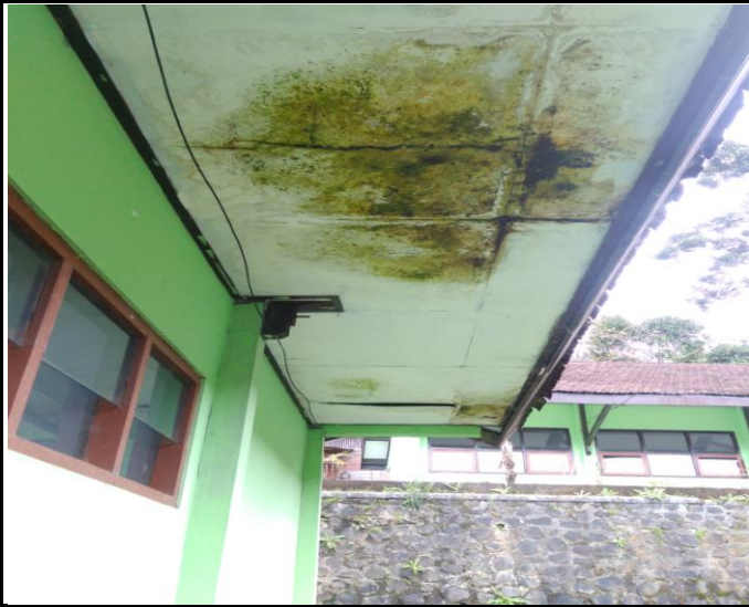
Ruang Kepala Sekolah dan Ruang Kesenian - plafon teras belakang
